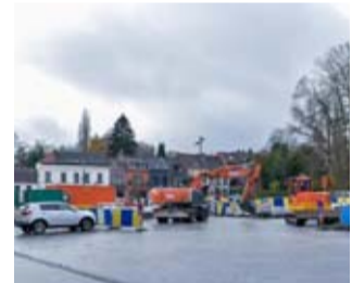
Pendant les travaux. © J.T.
